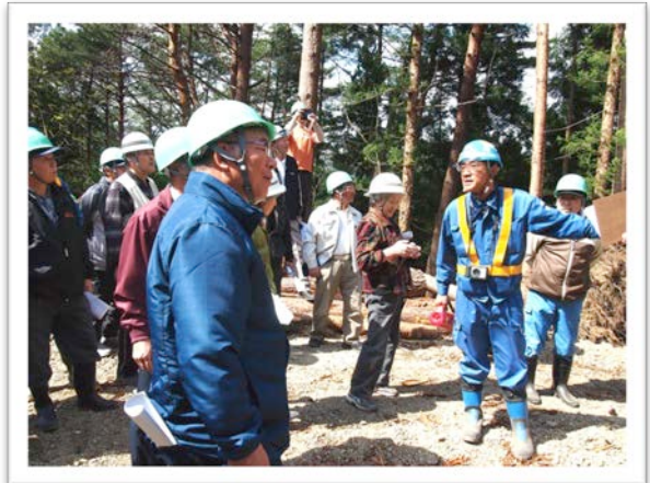
【根浜地区工事現場視察】
